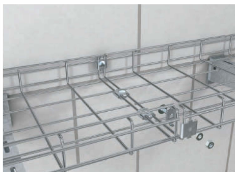
Montaje de una bandeja de rejilla con uniones rectas atornilladas. Creación de una conexión recta atornillada de bandejas de rejilla con unión recta GSV 34.
